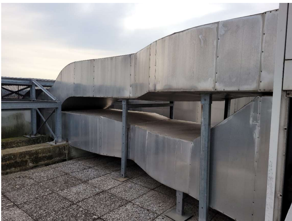
FOTO 4 – TRATTO DI CANALIZZAZIONI DA MODIFICARE PER I NUOVI ROOF TOP
