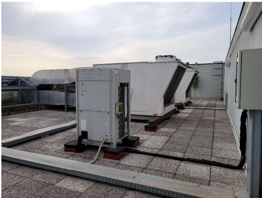
FOTO 3 - ROOF TOP DA SOSTITUIRE CON I NUOVI
