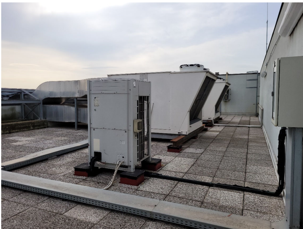
FOTO 3 - ROOF TOP DA SOSTITUIRE CON I NUOVI
