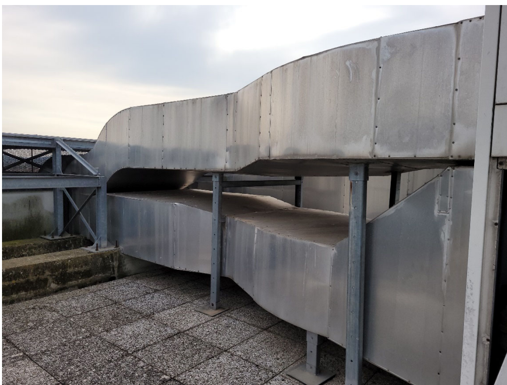
FOTO 4 – TRATTO DI CANALIZZAZIONI DA MODIFICARE PER I NUOVI ROOF TOP
